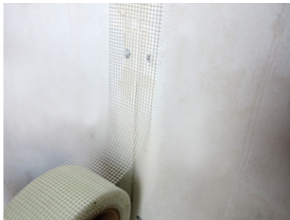
Zapolnite spoj z enim tankim slojem in nato nanesite mrežast trak za ojačitev
