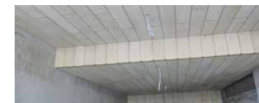
V primeru neravne površine stropa lamela omogoči optično izravnavo površine zaradi poševnega roba po obodu.
