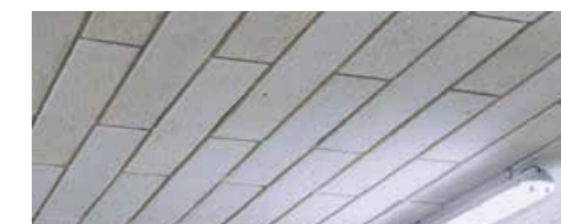
Lamela se na notranje stropse samo lepi in ne potrebuje mehanskega pritrdjevanja. Zaključna obdelava ni potrebna.
