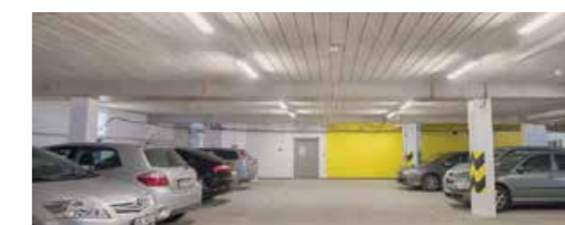
Lamele CLT C1 Thermal uporabljamo za toplotno, zvočno in požarno zaščito stropov neogrevanih kleti, garaž in drugih servisnih prostorov.
