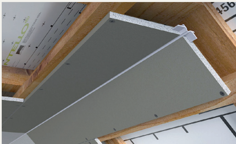
Prehod med poševnino in stropom
