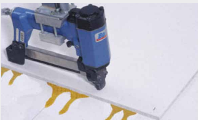
Slika 5: Povezava obeh slojev fermacell s sponkami.
