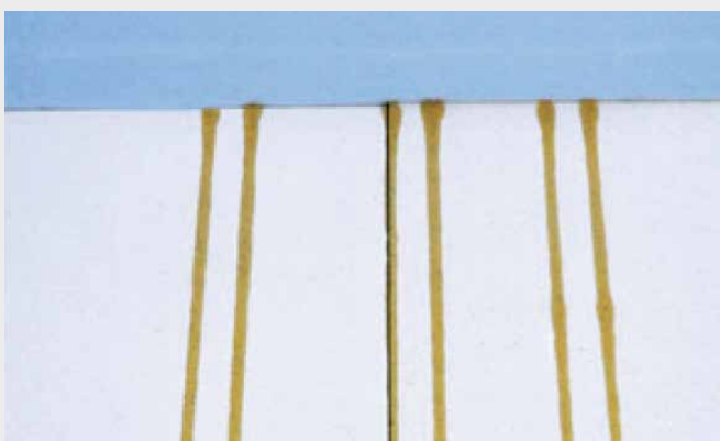
Slika 3: Iztisk lepila na vsakokratni stik prvega sloja fermacell plošč. Nanos lepila za estrih fermacell z dvojno šobo, razmak med iztiskoma maks. 100 mm.
