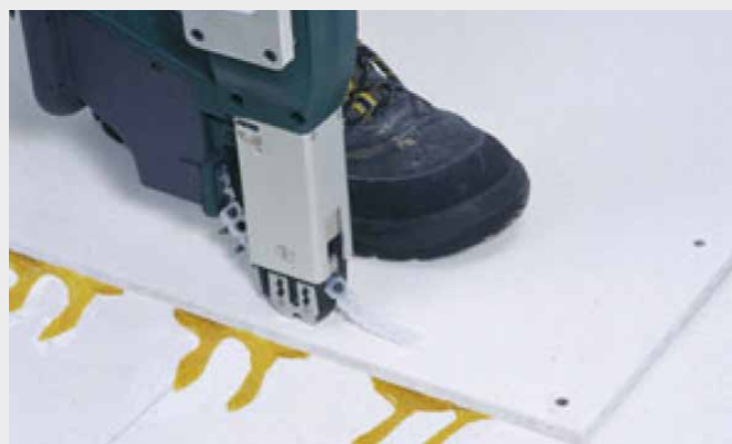
Slika 6: Povezava obeh slojev fermacell z vijaki.
