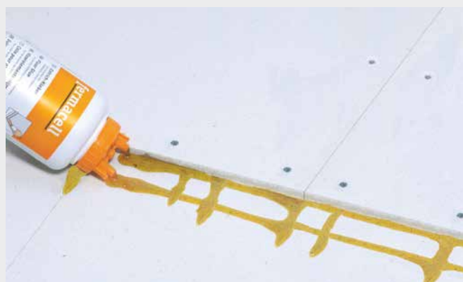
Slika 4: Iztisk lepila na rob plošče drugega sloja fermacell plošč. Lepljenje zgornjega stika z nanosom iztisnjene lepila maks. 10 mm od roba (poteka samodejno z vodenjem plastenke lepila po robu plošče).
