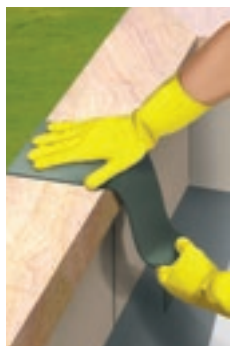
Položimo na podlago
